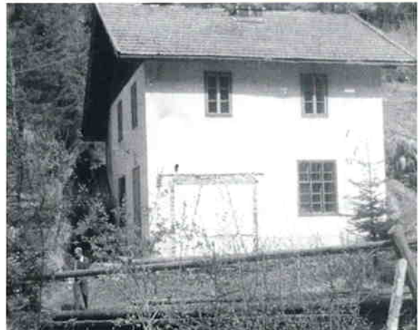
Das Elektrizitätswerk der Familie Marberger, damals eine kleine Sensation
