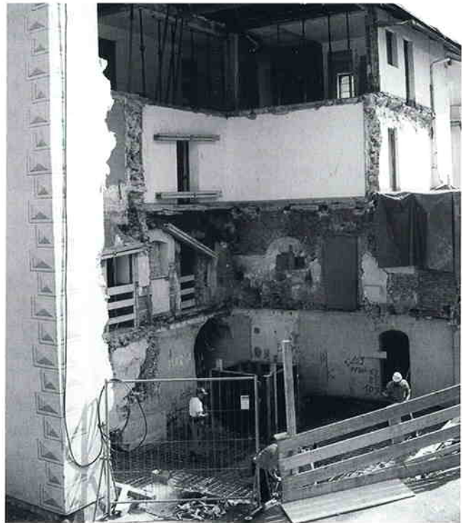
Die Umbauarbeiten in ein modernes Gemeindehaus erwiesen sich als sehr aufwendig.
